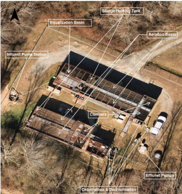
Existing Etowah WWTP
